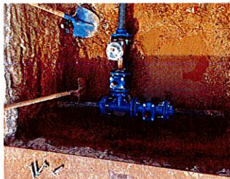
Photo : Mise en place d'un comptage d'eau sur une antenne de la commune d'Arbellara
